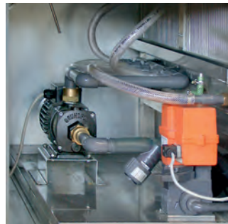
Cirkulationspump för evaporativ kylning
